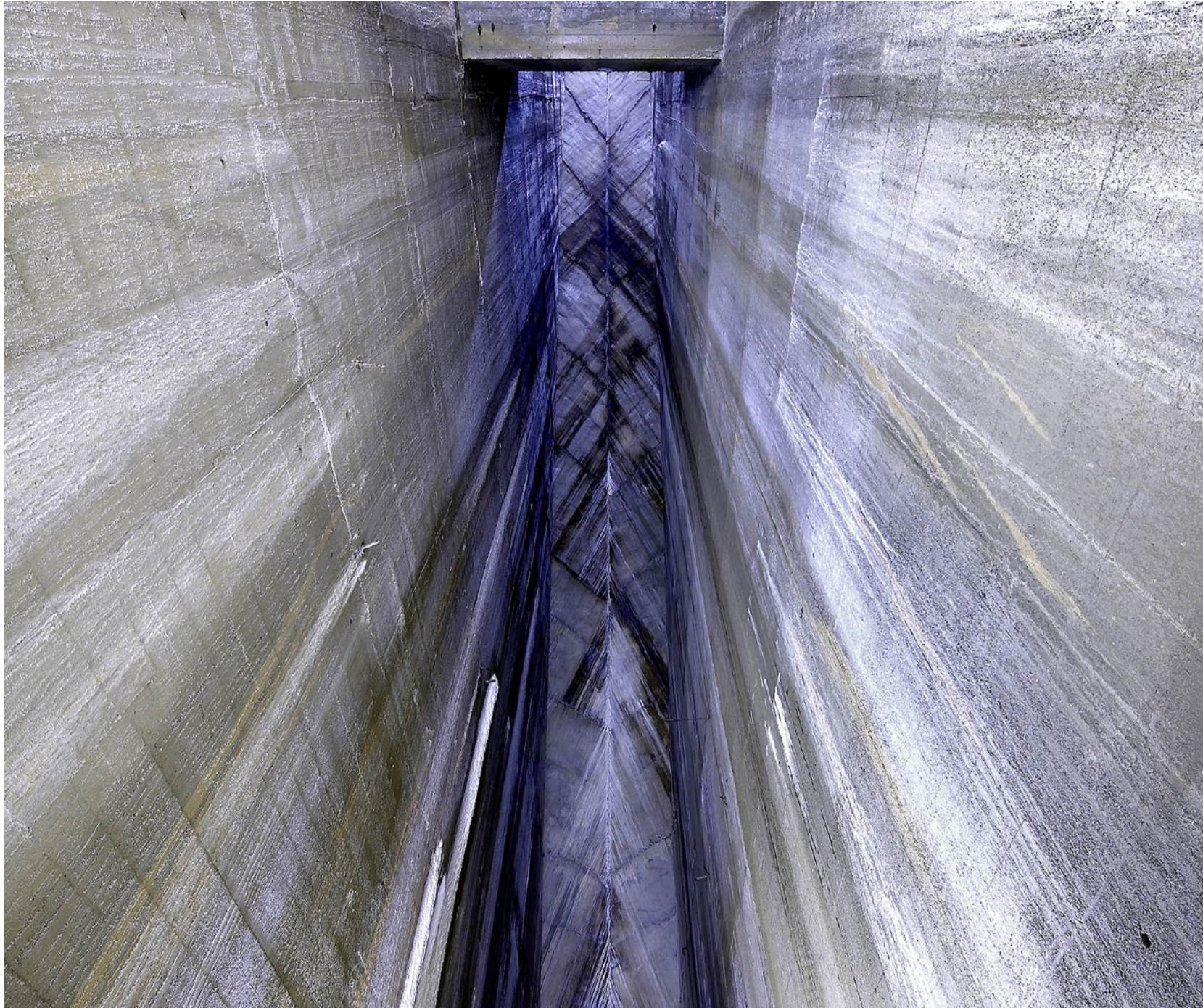
Innenansicht einer Staumauer: Jenseits der 94 Meter hohen Staumauer liegt der Räterichsbodensee mit einem Fassungsvermögen von bis zu 25 Millionen Kubikmetern. Er gehört zu einem Kraftwerkpark rund um die Pässe Grimsel und Susten mit weiteren sechs Stauseen, einem natürlichen See, neun Kraftwerken und 130 Kilometern Stollen.
